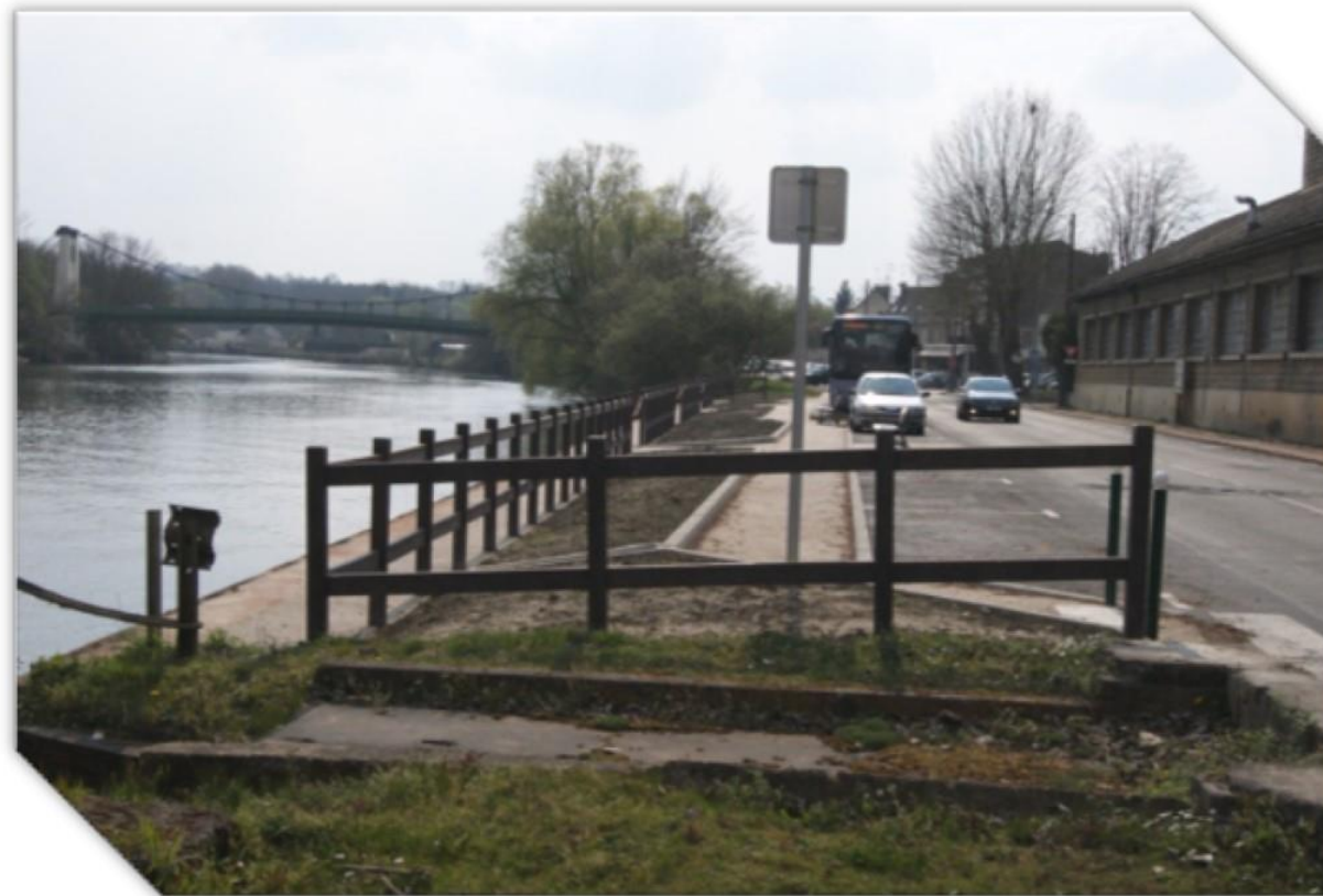
JANVIER 2014 : AMENAGEMENT DU QUAI D'AMONT
